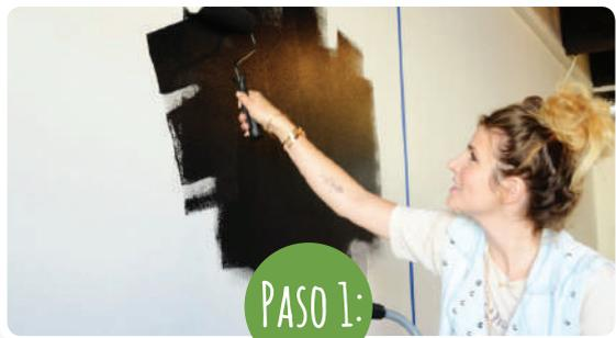
Vierte la pintura de pizarra MONOPOL en una bandeja de pintura. Pasa una capa en el área escogida usando un rodillo. Siempre de arriba para abajo o de abajo para arriba.
